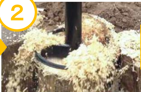
バックホーを操作し、切削
