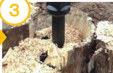
必要な深さまで掘り進め、完了
